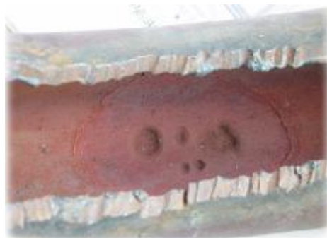
图 8 停炉处理不当产生的腐蚀坑
