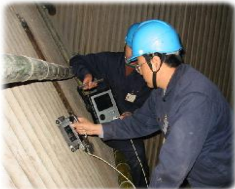
图 4 电厂水冷壁管 检测现场图一
