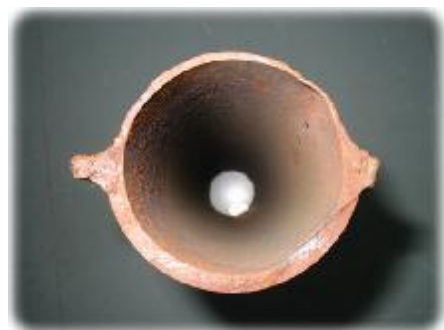
图 11 管壁单侧均匀减薄
