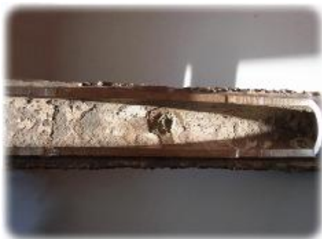
图 7 水冷壁管坑状腐蚀
