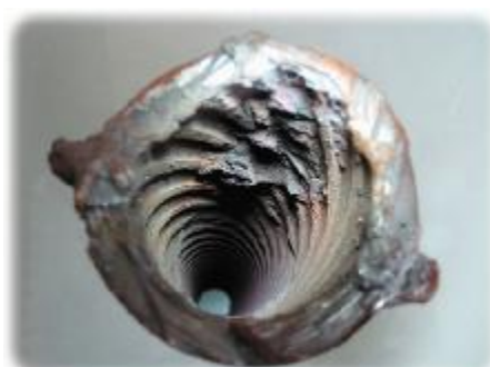
图 12 螺旋管内壁腐蚀坑
