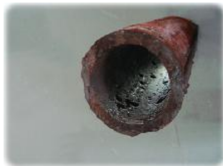
图 10 发生多处麻坑氢腐蚀
