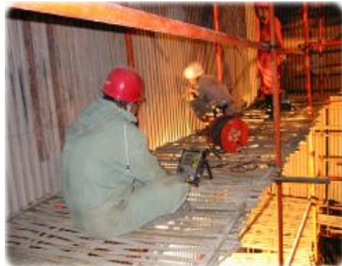
图 5 电厂水冷壁管 检测现场图二
